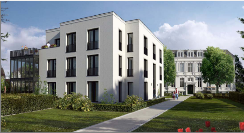
Mehrfamilienhaus im „Quartier Brüderstraße“
