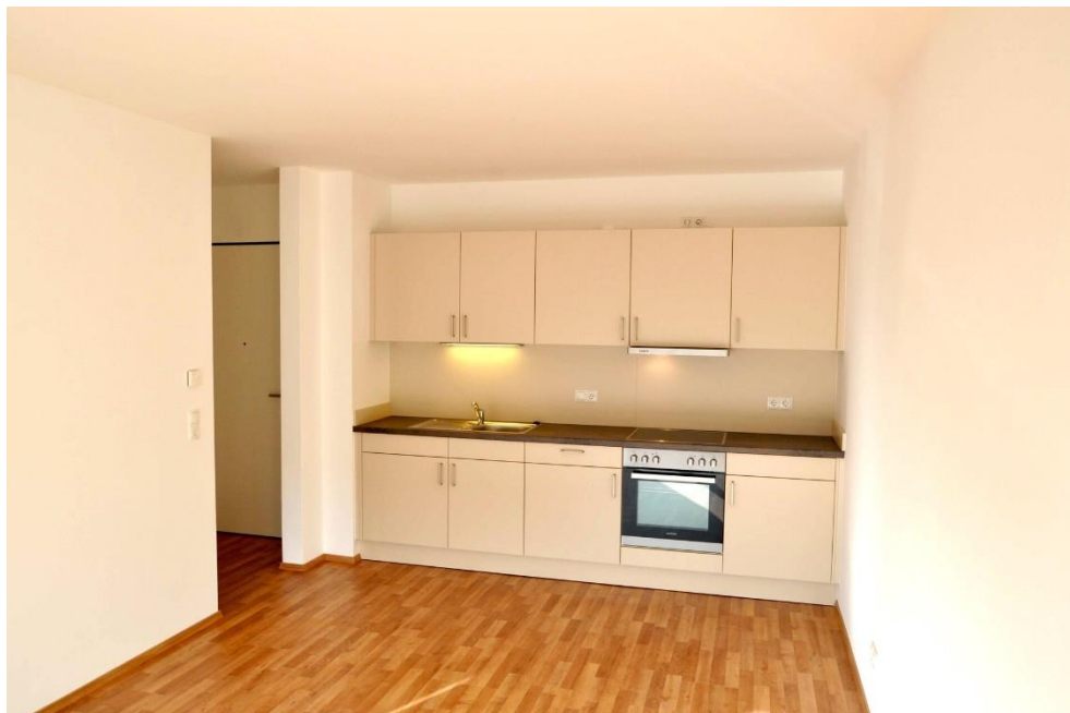
Küchenzeile bei Fertigstellung
