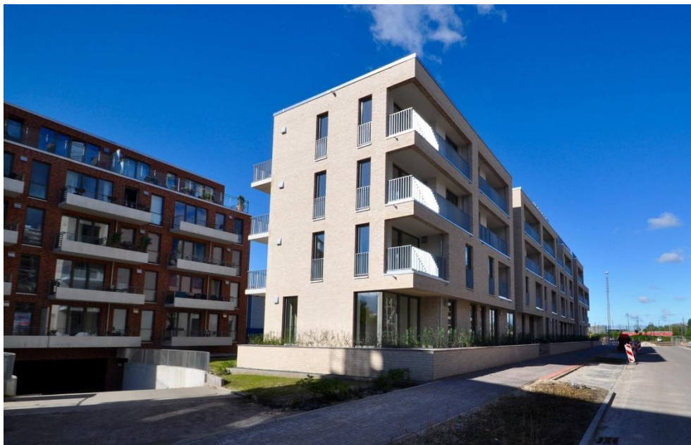
Außenansicht bei Fertigstellung
